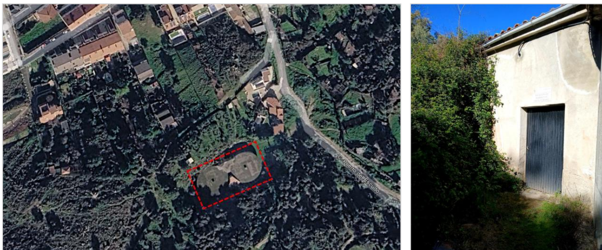
Imagen 15. Ubicación en planta y vista general de los depósitos y estación de bombeo en Navalморal de la Mata.
