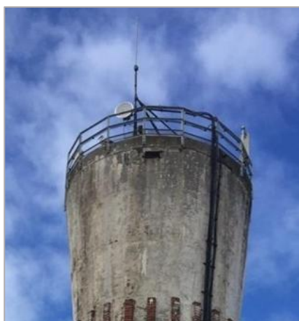
Imagen 45. Parte superior del depósito de copa
