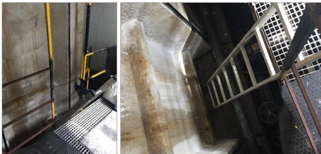
Imagen 47. Escalera de acceso a la sala de llaves del depósito de regulación
