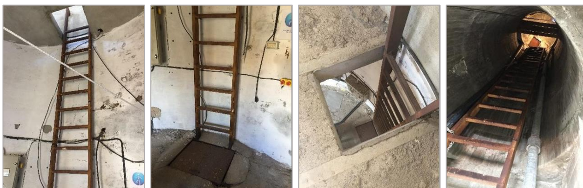
Imagen 48. Escalera fija de acceso al vaso superior del depósito de copa
