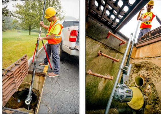
Figura 10. Inspección del pozo de registro con la cámara de inspección con pértiga.
