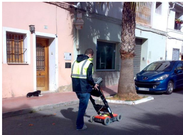
Figura 16. Ejemplo de utilización de georradar.
